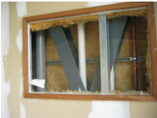
Abb. 21: Blick in eine Innenwand
