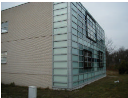
Abb. 18: Die Ziegelwand wurde industriell vorgefertigt, die Holz-Fensterrahmen mit Fixverglasung sind ein Standardprodukt.
