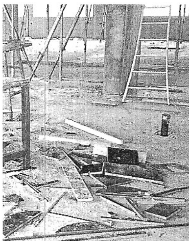
Een afvalbak bij deze zaagmachine zou het afval beter scheiden en een schone werkplek opleveren.
